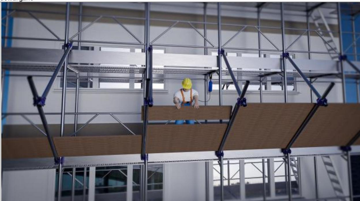
Per posizionare l'ultima fila di tavole il lavoratore in quota dovrà agganciare, in posizione verticale, il DPI anticaduta retrattile al punto di ancoraggio, quindi, oltrepassare il parapetto e montare le tavole.
