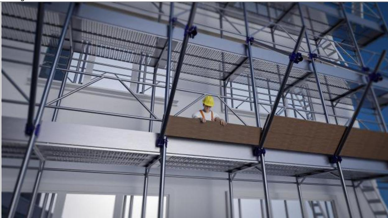
Un lavoratore posizionato sull'impalcato provvisto di parapetto e tavola fermapiède posizionerà le prime file di tavole fissando i meccanismi di blocco.
