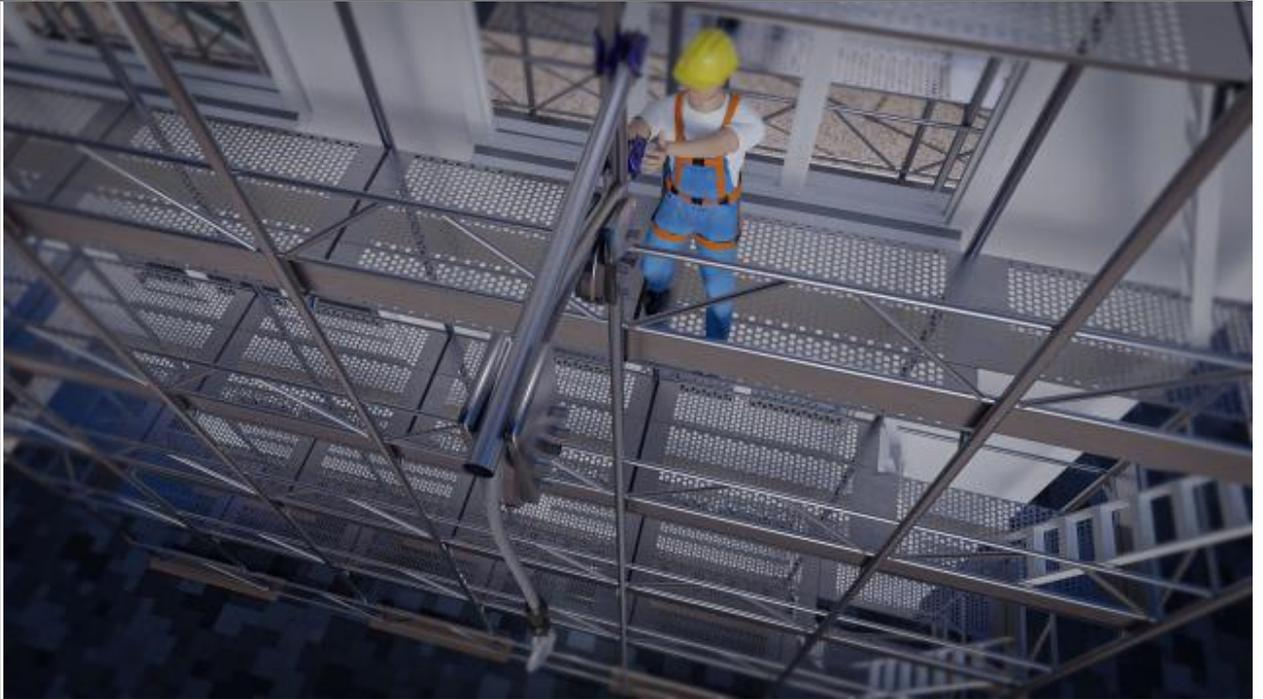
I lavoratori, posizionati sull'impalcato inferiore a quello da allestire, monteranno un argano su un montante esterno.
