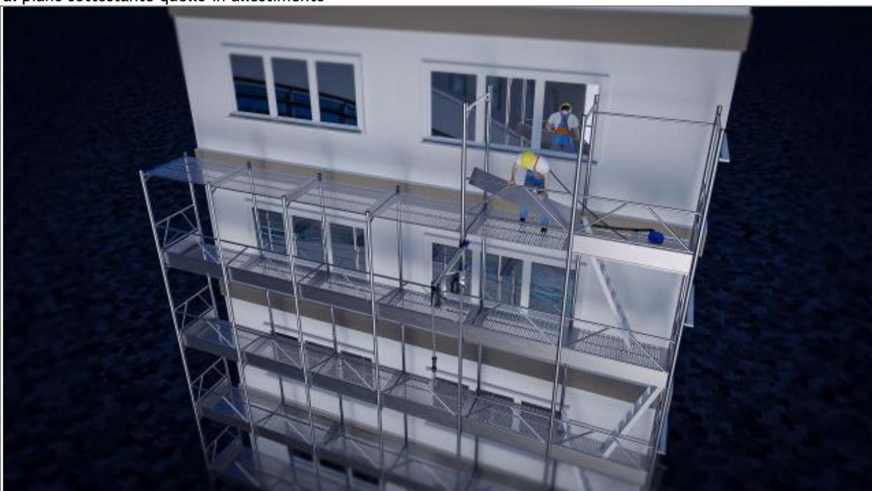
Il lavoratore in quota, posizionato sull'impalcato da smontare, dopo aver collegato il DPI anticaduta retrattile al punto di ancoraggio, realizzato all'estremità di un montante interno, smonterà gli elementi del ponteggio, a seconda di quelli presenti, nel seguente ordine: scala, diagonali di facciata, diagonali in pianta, tavole dell'impalcato superiore, correnti interni, tavole fermapiède, telaio-parapetto, ancoraggi, spine a verme e telai.
