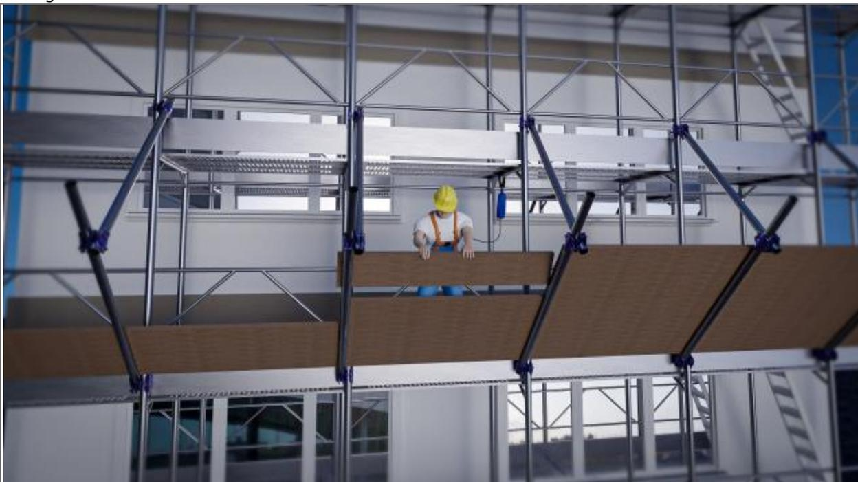
Per smontare l'ultima fila di tavole della mantovana il lavoratore in quota dovrà agganciare, in posizione verticale, il DPI anticaduta retrattile al punto di ancoraggio, quindi, oltrepassare il parapetto e smontare le tavole. Gli elementi della mantovana saranno portati a terra mediante "passamano" o argano.
