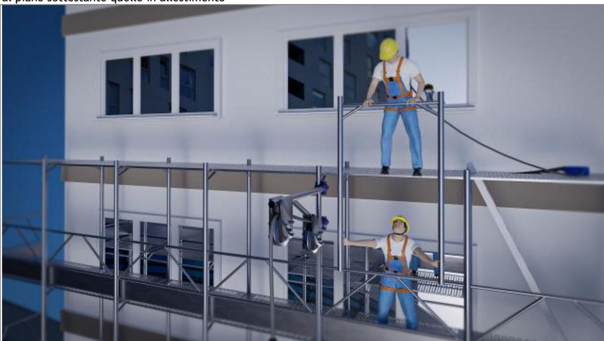
Il lavoratore in quota, mediante "passamano", passerà ai lavoratori, posti al piano inferiore a quello da smontare, gli elementi del ponteggio smontati; i lavoratori potranno quindi calarli a terra mediante l'argano.
