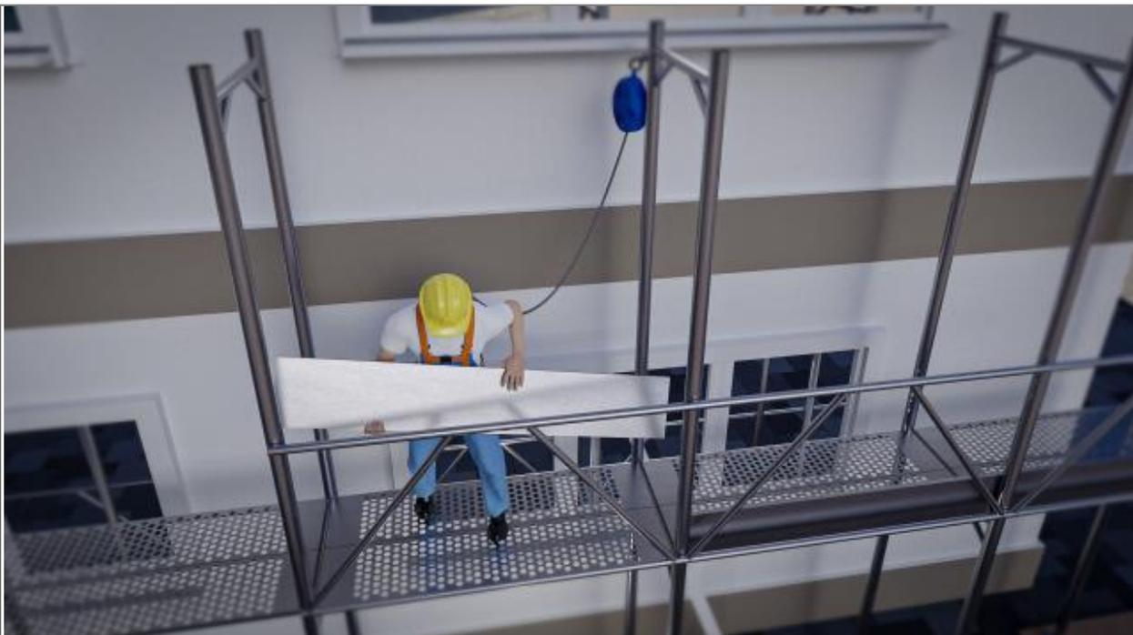
Il lavoratore, posizionato sull'impalcato da smontare, dopo aver collegato il DPI anticaduta retrattile al punto di ancoraggio, realizzato su un traverso, smonterà gli elementi del ponteggio, a seconda di quelli presenti, nel seguente ordine: scala, diagonali di facciata, diagonali in pianta, tavole dell'impalcato superiore, correnti interni, tavole fermapiede, telaio-parapetto, ancoraggi, spine a verme e telai.
