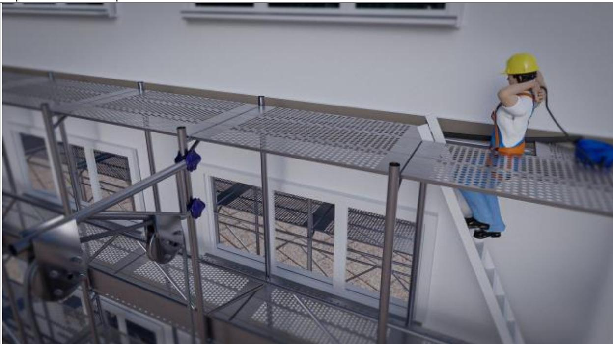
Il lavoratore in quota, per accedere all'impalcato inferiore da smontare, si posizionerà sulla scala d'accesso all'impalcato inferiore e solo a quel punto sgancerà il moschettone del DPI anticaduta retrattile dall'imbracatura. Ripetendo gli step da A a C si smonteranno tutti gli impalcati.
