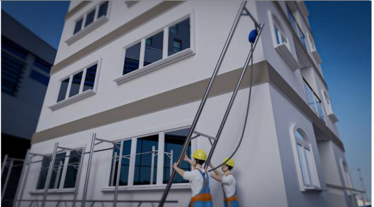
I lavoratori dovranno realizzare, sul traverso di un telaio sovrapposto a quello di base, un punto di ancoraggio a cui collegare il DPI anticaduta retrattile. Il moschettone del DPI, che andrà collegato all'imbracatura, dovrà essere fissato temporaneamente al montante in corrispondenza della quota dell'impalcato superiore. I lavoratori, quindi, monteranno i telai sulle basette, i telai-parapetto e i correnti interni.
