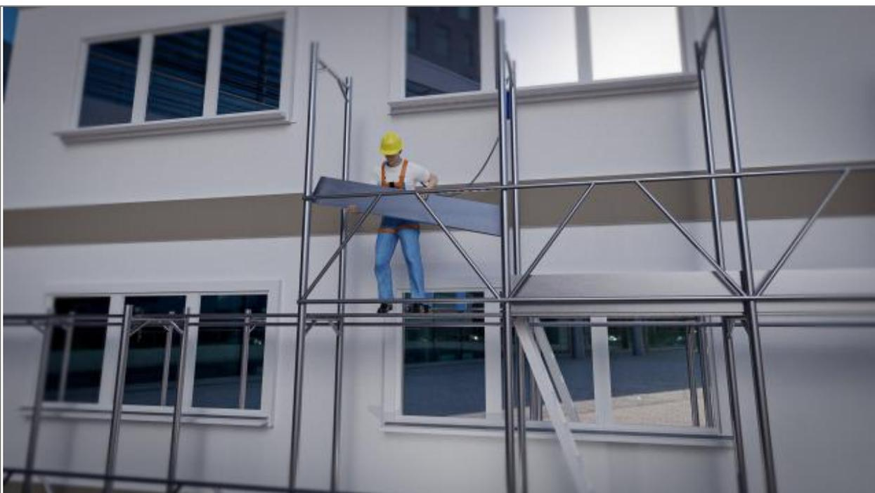
Il lavoratore in quota monterà gli elementi del ponteggio, a seconda di quelli necessari, nel seguente ordine: telai, spine a verme, telaio-parapetto, parapetto di testata e tavole fermapiede.
