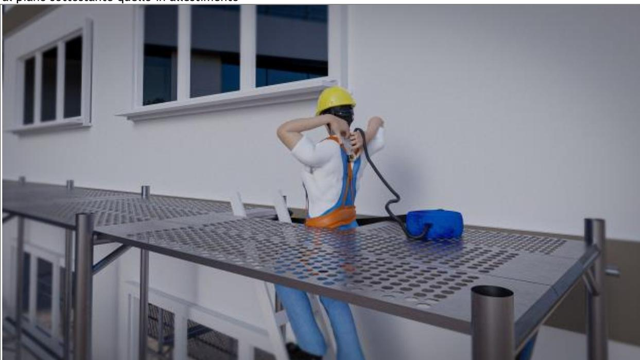
Il lavoratore in quota, dotato di imbracatura e posizionato sulla scala d'accesso, aggancerà il moschettone del DPI anticaduta retrattile all'imbracatura e si porterà sull'impalcato da montare.
