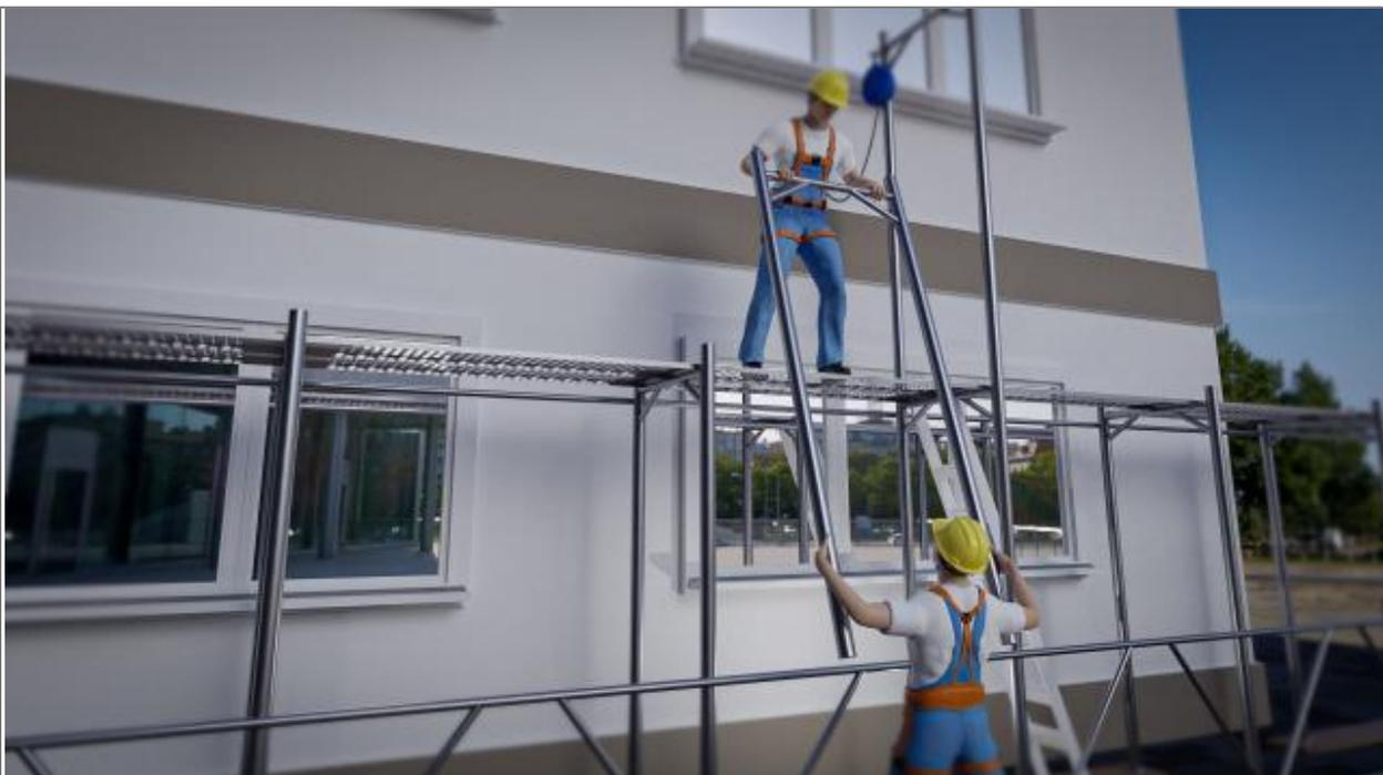
I lavoratori, mediante "passamano", passeranno al lavoratore in quota gli elementi del ponteggio da montare.
