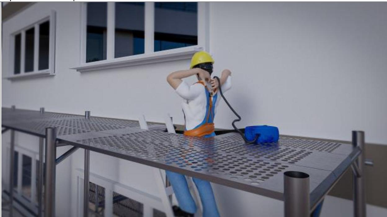
Il lavoratore in quota, dotato di imbracatura e posizionato sulla scala d'accesso, aggancerà il moschettone del DPI anticaduta retrattile all'imbracatura e si porterà sull'impalcato da montare.
