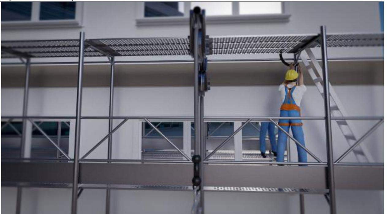
I lavoratori, sempre posizionati sull'impalcato inferiore a quello da allestire, realizzeranno un punto di ancoraggio in corrispondenza del montante interno posto vicino alla scala di accesso all'impalcato superiore e collegheranno a questo un DPI anticaduta retrattile.
