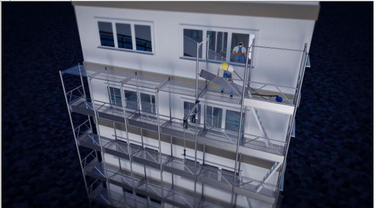
Il lavoratore in quota, posizionato sull'impalcato da smontare, dopo aver collegato il DPI anticaduta retrattile al punto di ancoraggio, realizzato all'estremità di un montante interno, smonterà gli elementi del ponteggio, a seconda di quelli presenti, nel seguente ordine: scala, diagonali di facciata, diagonali in pianta, tavole dell'impalcato superiore, correnti interni, tavole fermapiède, telaio-parapetto, ancoraggi, spine a verme e telai.
