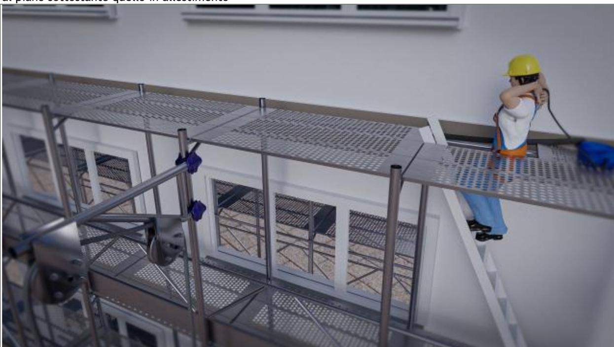
Il lavoratore in quota, per accedere all'impalcato inferiore da smontare, si posizionerà sulla scala d'accesso all'impalcato inferiore e solo a quel punto sgancerà il moschettone del DPI anticaduta retrattile dall'imbracatura. Ripetendo gli step da A a C si smonteranno tutti gli impalcati.
