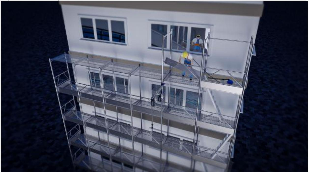
Il lavoratore in quota, posizionato sull'impalcato da smontare, dopo aver collegato il DPI anticaduta retrattile al punto di ancoraggio, realizzato all'estremità di un montante interno, smonterà gli elementi del ponteggio, a seconda di quelli presenti, nel seguente ordine: scala, diagonali di facciata, diagonali in pianta, tavole dell'impalcato superiore, correnti interni, tavole fermapiede, telaio-parapetto, ancoraggi, spine a verme e telai.
