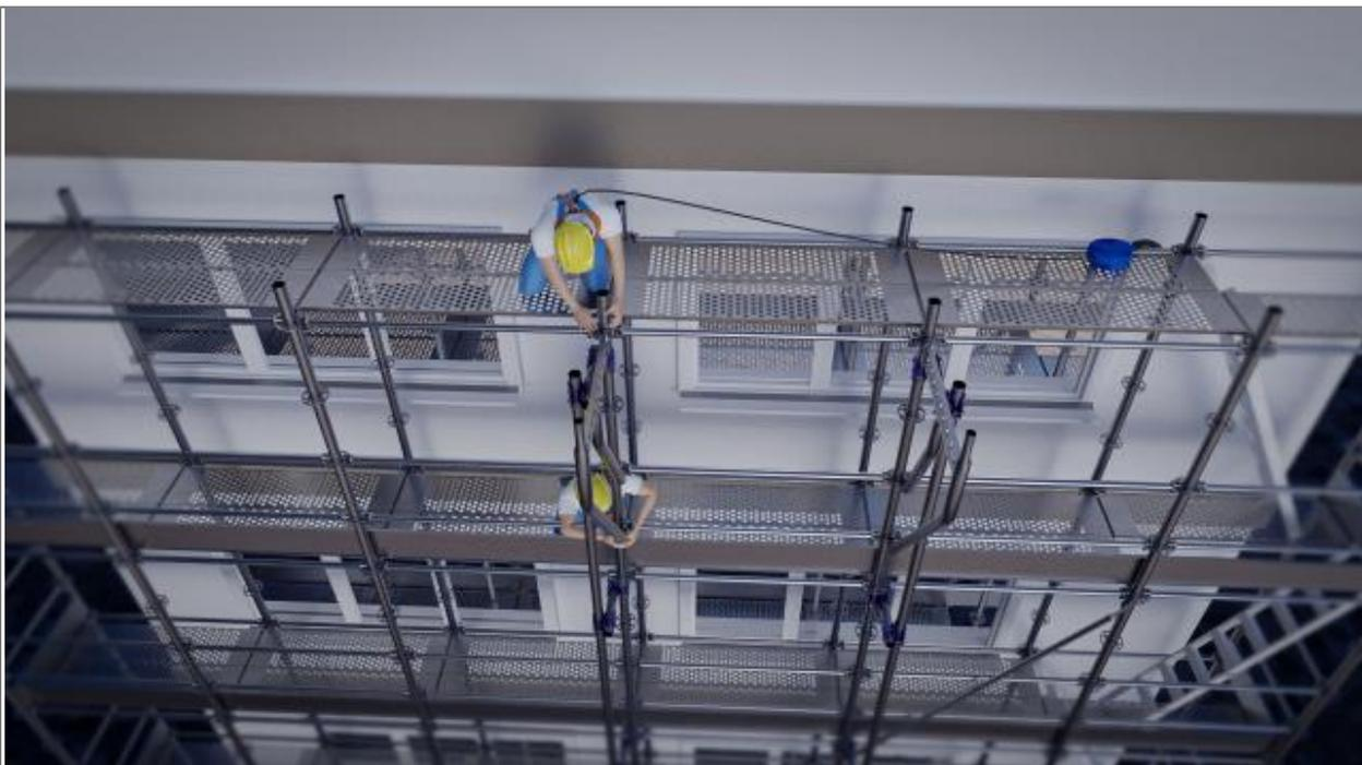
Il lavoratore in quota, sempre agganciato al DPI anticaduta, smonterà la mensola prefabbricata mentre il lavoratore posto al piano inferiore smonterà il puntone; una volta tolte le mensole prefabbricate, il lavoratore in quota si porterà sull'impalcato inferiore sganciando il DPI anticaduta solo dopo essersi posizionato sulle scale per la discesa.
