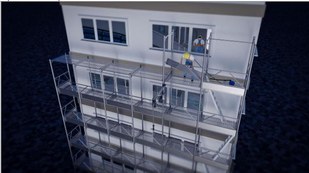
Il lavoratore in quota monterà gli elementi del ponteggio, a secondo di quelli necessari, nel seguente ordine: telai, spine a verme, telaio-parapetto, parapetto di testata e tavole fermapiede.
