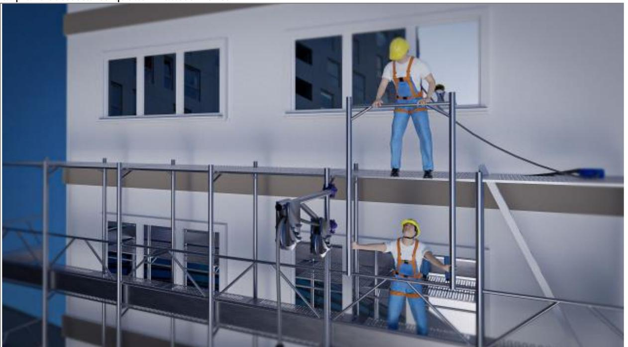
Il lavoratore in quota, mediante "passamano", passerà ai lavoratori, posti al piano inferiore a quello da smontare, gli elementi del ponteggio smontati; i lavoratori potranno quindi calarli a terra mediante l'argano.
