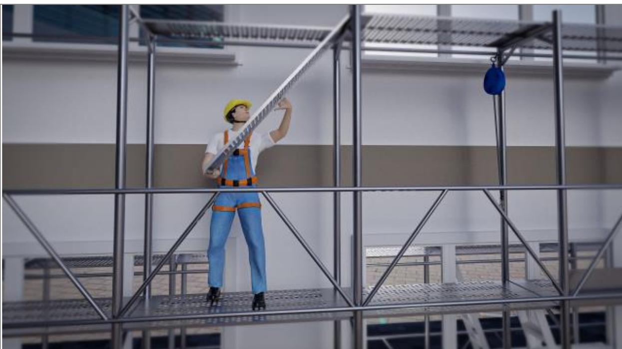
Il lavoratore in quota sgancerà dall'imbracatura il moschettone del DPI retrattile e lo fisserà temporaneamente al montante, a cui è ancorato il DPI, in corrispondenza della quota dell'impalcato superiore, quindi monterà i correnti interni, le tavole dell'impalcato superiore, le diagonali in pianta, le diagonali di facciata, gli ancoraggi e le scale di accesso all'impalcato superiore. Ripetendo gli step da C a F si monteranno gli altri impalcati.
