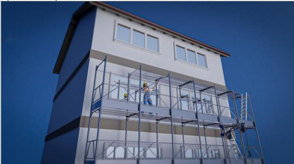
Il lavoratore in quota sgancerà dall'imbracatura il moschettone del DPI retrattile quindi monterà i correnti interni, le tavole dell'impalcato superiore, le diagonali in pianta, le diagonali di facciata, gli ancoraggi e le scale di accesso all'impalcato superiore. Ripetendo gli step da A a F si monteranno gli altri impalcati.
